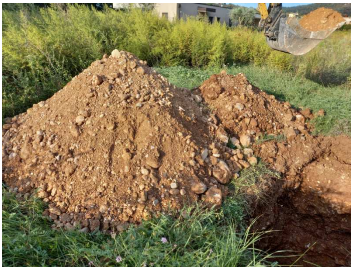
Cumulo dei depositi ghiaioso sabbiosi rinvenuti durante l'esecuzione dello scavo esplorativo n. 1
