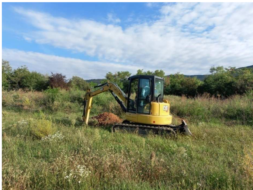
Esecuzione scavo esplorativo T3 visto da sud-est
