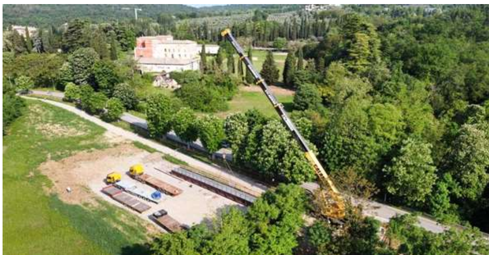
Castion: posa del ponte sul Tesina della ciclabile
