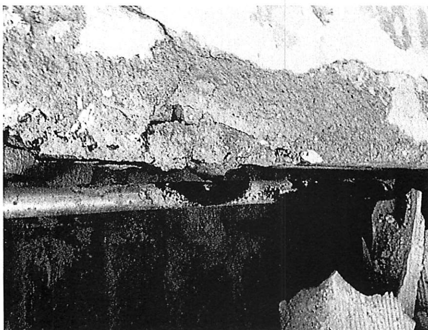
Foto 5 – Impianto adduzione idrico – tubazione ammalorata
