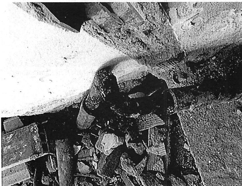
Foto 1 – colonna montante impianto termico – tubazione ammalorata
